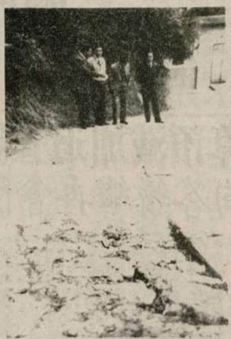
北竿道路破損情形。(吳依水攝)
