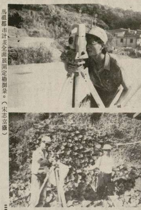
馬祖地區計畫全面展開定樁測量。(宋志富攝)
