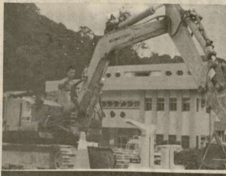
陸地路橋工程已進行鋪設，並做部分交通管制。（宋志富攝）
