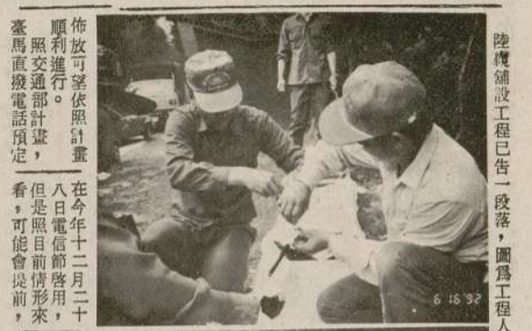
陸纜舖設工程已告一段落，圖為工程人員接線及其設備。(吳依水攝)
