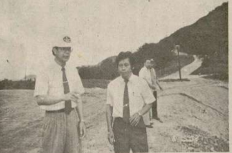
北竿坂里水庫工程進度良好，圖為工程人員在現場工作。(吳依水攝)
