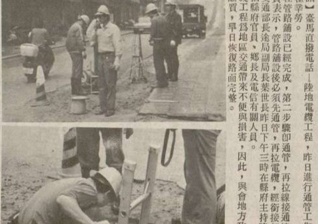
電信技術人員冒雨進行陸纜通管工程。
