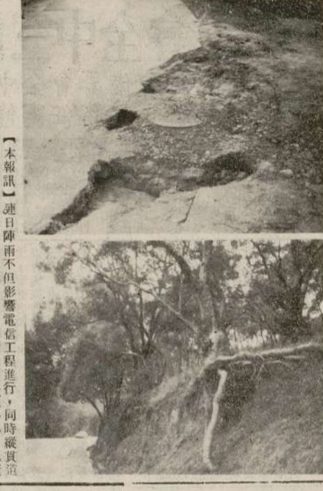
電信工程造成道路阻礙及行道樹傾倒情形。(吳依水攝)
