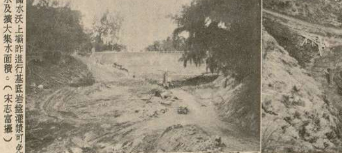
儲水壩上壩昨進行基礎灌漿工程，預計於下月完成。
