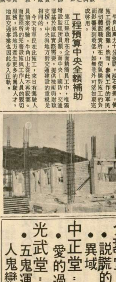
監理所工程積極施工中。(吳依水攝)
