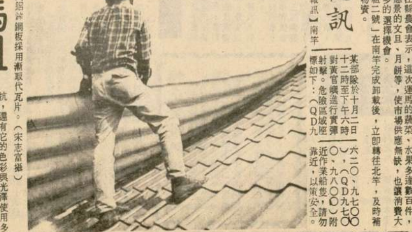
馬祖地區掀起一片「鋁鋅鋼板」熱，居民紛紛採用鋁鋅鋼板來裝飾房屋。
