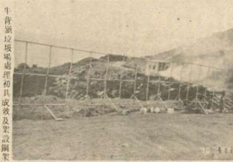
牛背嶺垃圾場處理初具成效及架設鋼架網面接近完成。(宋志富攝)
