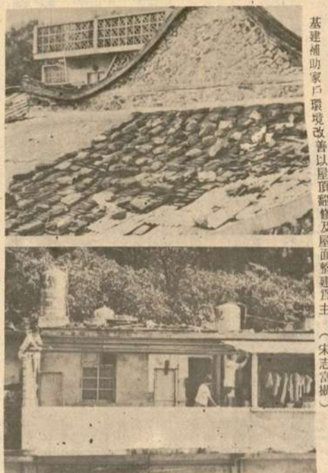
基建補助改善居住環境，以屋頂修繕及屋面整建為主。(宋志富攝)
