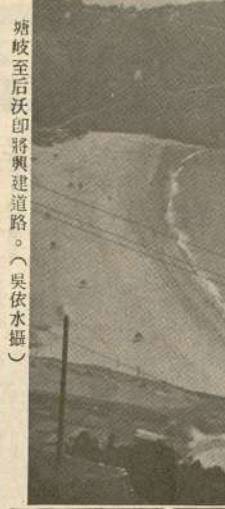
路因興建在沙灘上，工程十分艱巨。圖為第二期再鋪設水泥路面。圖為第一期工程，預計於明年一月動工，預計於明年六月完工。
