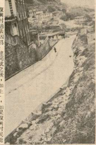
復興村道路工程積極施工。(吳依水攝)
