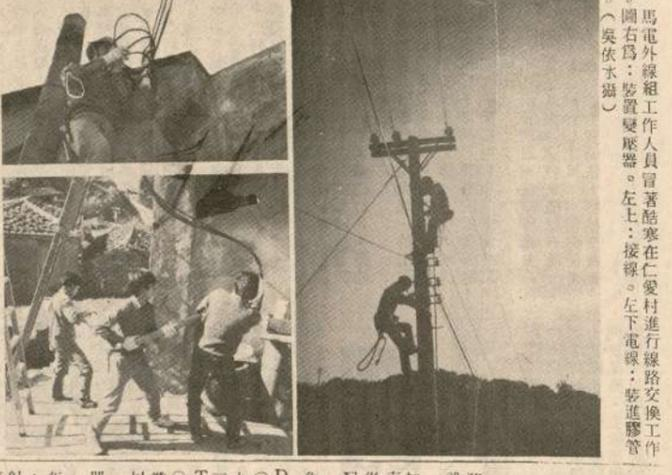
馬電外線組工作人員冒著嚴寒在仁愛村進行線路交換工作。圖右為：裝置變壓器。左下：接線。左下電線：裝進膠管。(吳依水攝)
