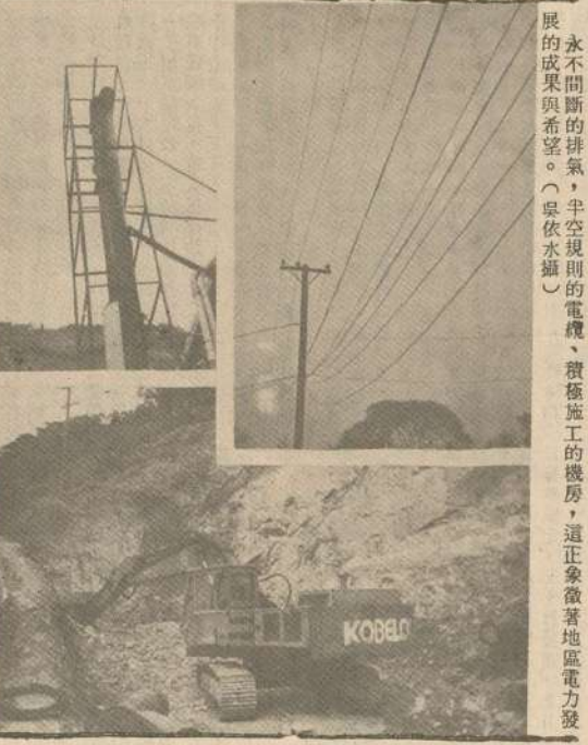
志清發電廠增機工程，進展極速，現已接近竣工。
