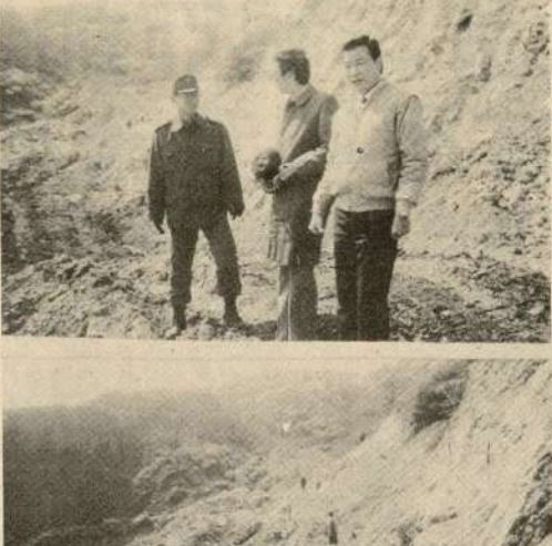
林縣長勘察工地期間官兵。下圖為開挖路基難情形。(吳依水攝)
