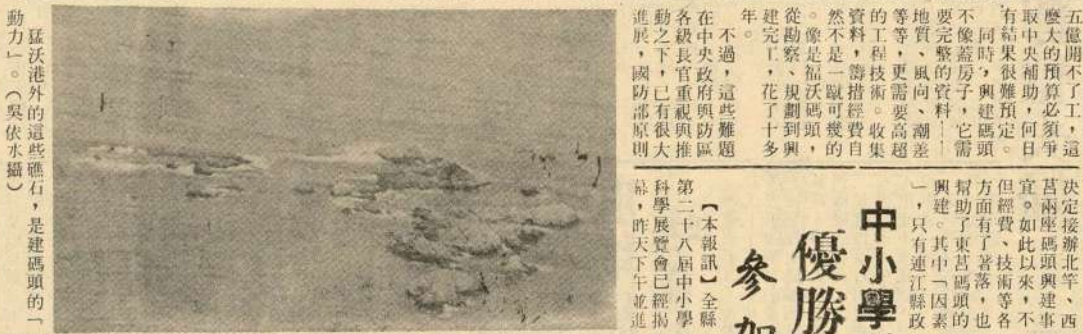
東莒碼頭興建工程，目前進展順利，預計年底可完工。
