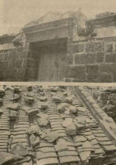
圖上：舊式瓦房排水之石魚瓦槽。圖下：瓦房頂交錯的天溝與瓦槽。
