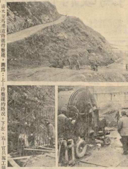
清水至馬路擴建工程進行中，圖為：上、待整修的路況。下左、右、官兵施工情形。(吳水清攝)
