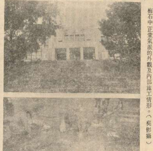
梅石中正堂氣派的外觀及內部施工情形。(吳影攝)
