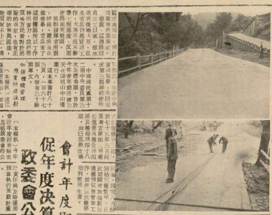
清水高路級路面，更將竣工，道平闊廣，堪稱一流。
