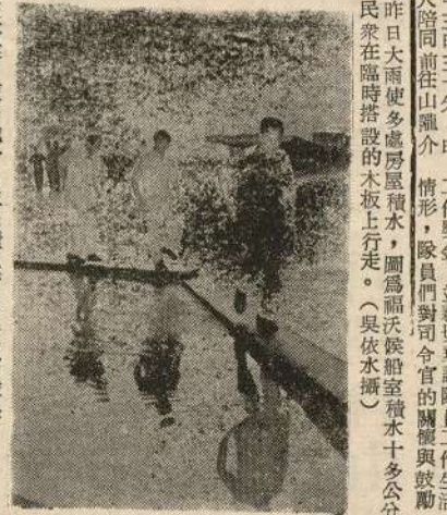
昨日大雨使多處房屋漏水，民眾在臨時搭設的木板上行走。(吳依水攝)
