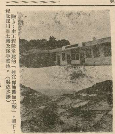
圖上：由工程隊承建的「連江縣漁產加工廠」。圖下：工程隊採用推土機及怪手整地。(吳依水攝)
