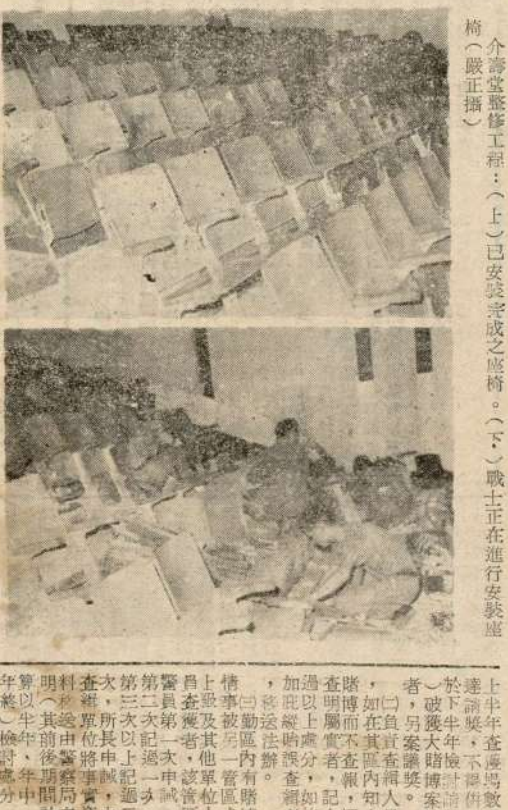
介壽堂整修工程：(上)已安裝完成之座椅。(下)戰士正在進行安裝。
