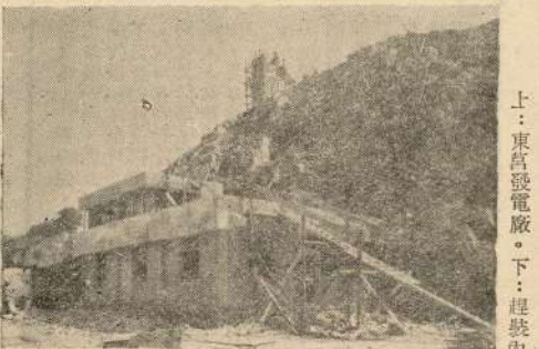
上：東高發電廠。下：趕裝內部機器。(嚴正攝)
